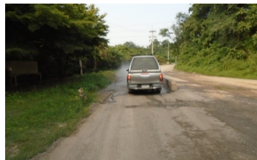
ภาพที่ 8-6 รถบรรทุกทุกคันปิดคลุมให้มิดชิดก่อนออกสู่ภายนอกโครงการและป่อฉีดล้างล้อรถก่อนออกสู่ ถนนลาดยางทางหลวง 21
